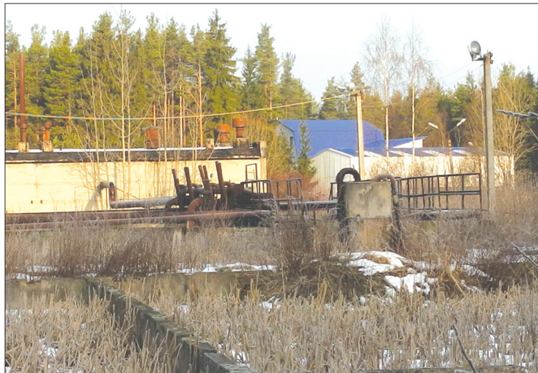
Очистные сооружения Рощина не работают. Отходы жизнедеятельности трех тысяч жителей без очистки попадают в реку Рощинку и Финский залив
